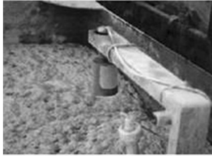
LR725F 应用于明渠流量计 测量堰槽污水的瞬时流量和累积流量
